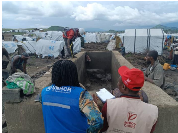
Construction d'une fosse septique dans le site de Lushagala Extension au Nord Kivu © CLUSTER CCCM RDC AVRIL 2024
