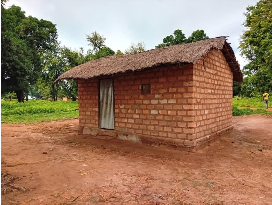
Abri de retour à Paoua avec la toiture en paille
