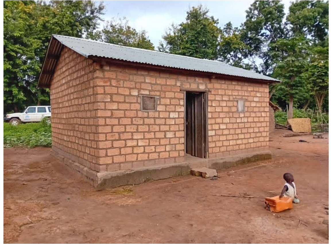
Abri de retour à Paoua avec la toiture en tôle
